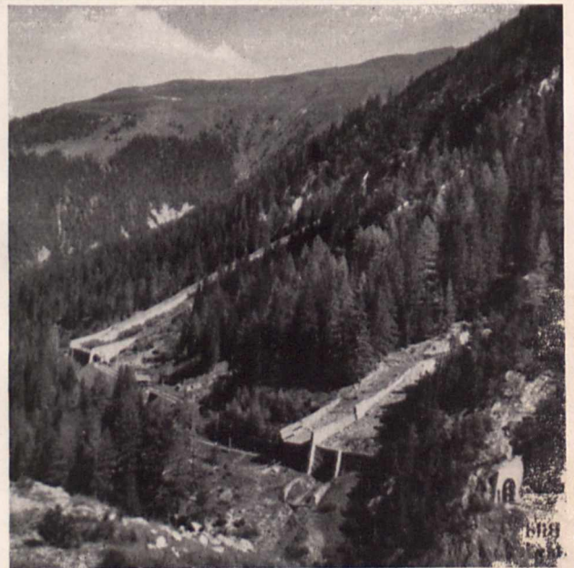
Bild 4. Lawinengalerien führen die Schneerutsche der „Züge“ über die Bahnlinie hinweg
