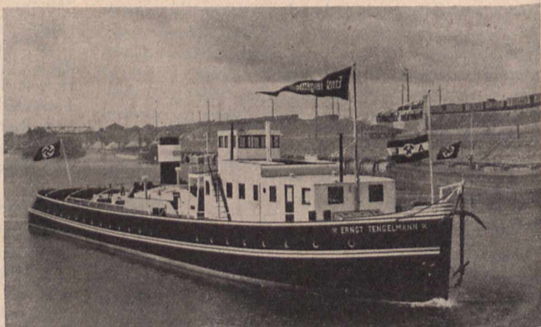
Bild 2. Dreischraubenschlepper mit Gasantrieb Das Fahrzeug ist 43 m lang und 7,5 m breit. Die Maschinenanlage leistet in drei Motoren maximal 930 PS. Der Schlepper ist imstande, 3750 t (entspricht etwa 250 Güterwagen) in normaler Schleppzeit stromauf zu ziehen. Das Fahrzeug zeigt einige schiffbautechnische Neuerungen. Die Drehzahlverstellung der Motoren, die Umsteuerung der Wendegetriebe erfolgt ebenso wie die Lenkung durch den Schiffsführer vom Steuerhause aus. Es ist nicht notwendig, Kommandos in den Maschinenraum zu geben. Großer Wert wurde auf die Geräusch- und Erschütterungslosigkeit durch starke Durchbildung der Schiffskonstruktion gelegt Werkphoto: Humboldt-Deutz
