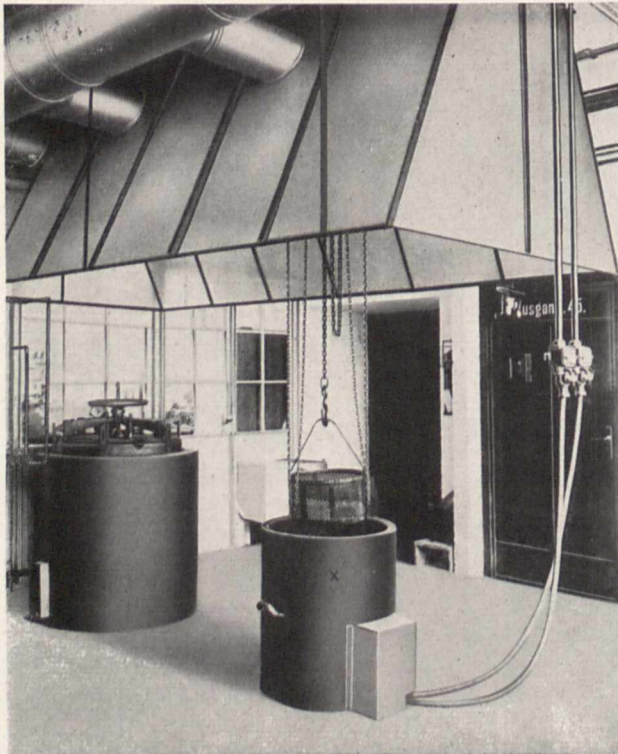
Bild 6. Elektrisch beheizte Zapon-Tränkerei und Evakuierungsanlage
