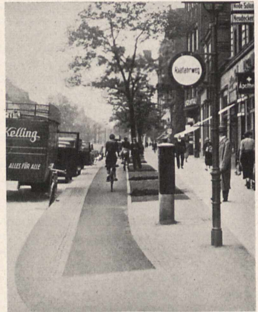
Bild 3. Eine besondere Gefahr bei seitlichen Radwegen in Stadtstraßen stellen die aufschlagenden Türen parkender Kraftwagen dar. In Breslau hat man zwischen der eigentlichen Fahrspur des Radweges und der Fahrbahn einen Sicherheitsstreifen vorgesehen, der lediglich dem Ueberholen dient
