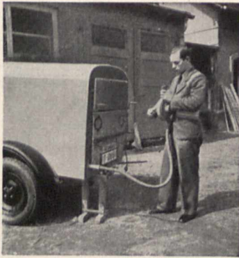
Bild 1. Rebenentseuchung mit Blausäure in fahbarem Autoanhänger
