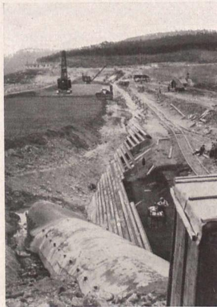
Bild 3. Die Stahlspundwand liegt schräg im Damm; sie schließt an die Betonmauer an
