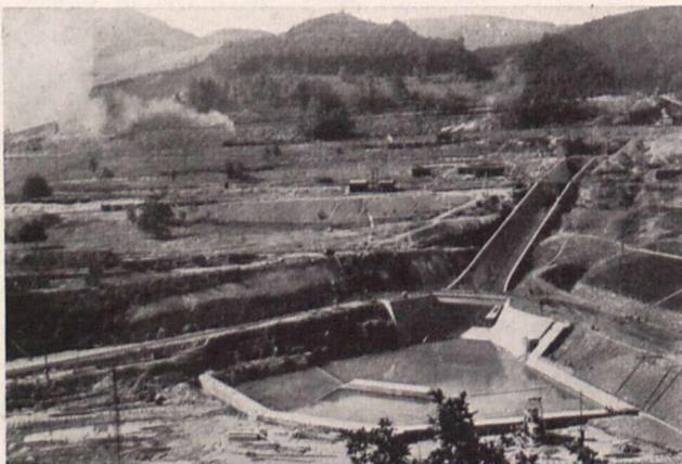
Bild 5. Im Tosbecken wird die Energie der herabschießenden Wassermassen unschädlich gemacht
