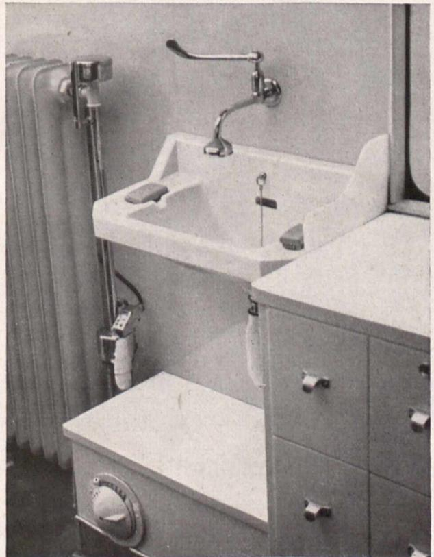
Bild 6. Wascheinrichtung kalt oder warm mit Schwenkbrausehahn, Warmwasserheizung, rechts Schreibtisch mit Kartothek
