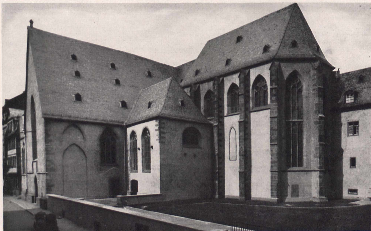
Bild 1. Freigelegte Südseite der Karmeliterkirche in Frankfurt a. M. (vgl. Bild 2) In der Mauer wird gerade noch ein Eingang zum Luftschutzkeller sichtbar
