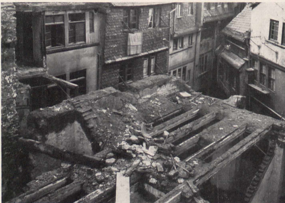
Bild 4. Auskernung hinter dem Fünffingerplatz in Frankfurt am Main
