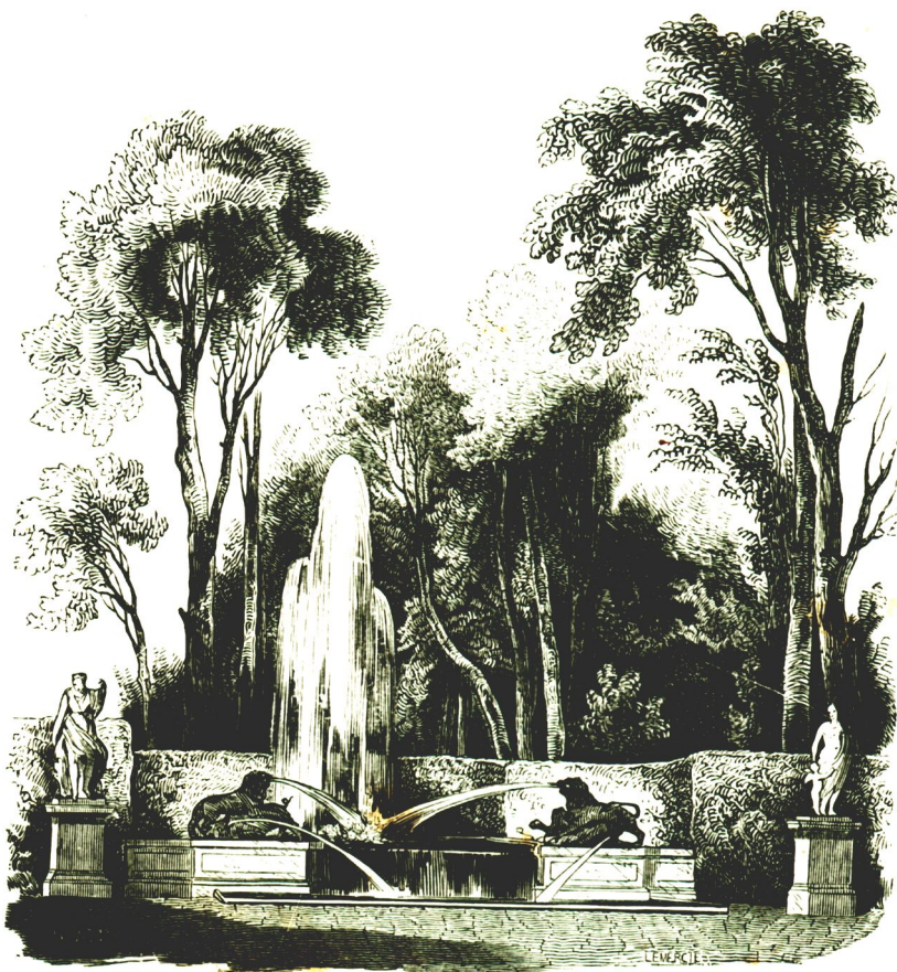
Bassin du Point du Jour.
