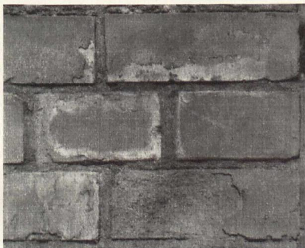
Bild 1. Mauerausschnitt mit Ausblühungen und Zerstörungserscheinungen
