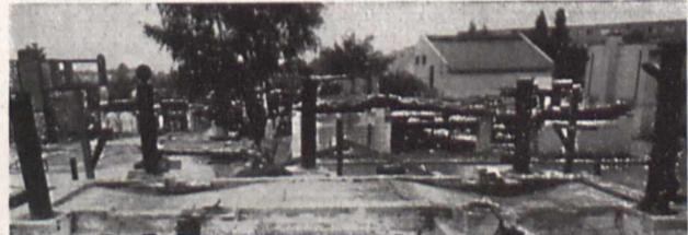
Bild 3. Brandversuche mit einer durchlaufenden Steineisendecke
