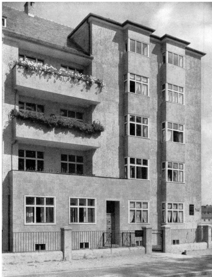
KLEINWOHNUNGSBAUTEN PAUL PUFKE, Breslau, Fürstenstrasse. 1927/28
