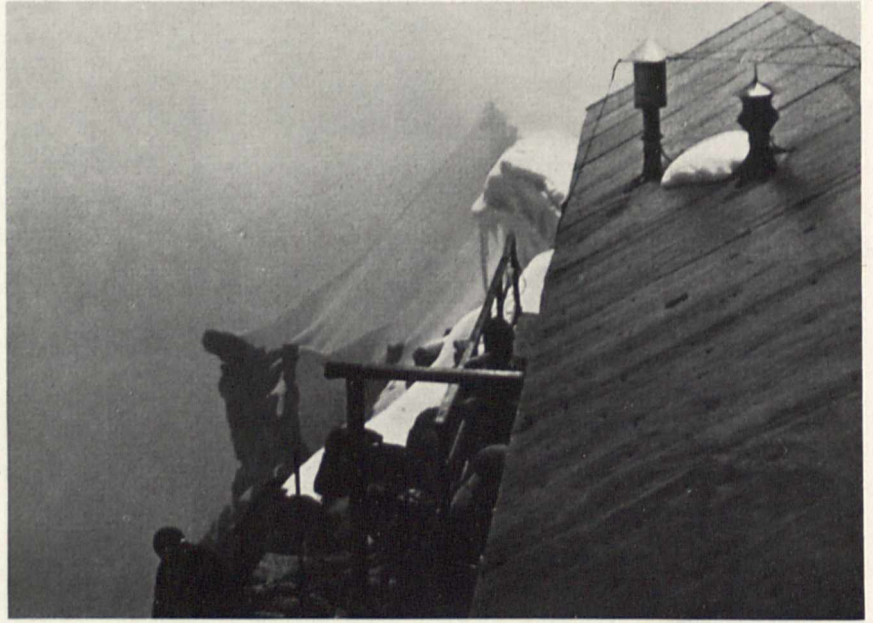
Bild 4. Das höchste wissenschaftliche Forschungslaboratorium der Welt, die Margherita-Hütte des Mosso-Institutes. — Blick auf das Dach der Hütte (rechts), auf die 20 m hohe Schneewächte, die jährlich in mehreren Lawinen abstürzt (Mitte Hintergrund) und auf die obere Kante des 2000 m tiefen senkrechten Steilabfalls der Monte-Rosa-Ostwand (links)
