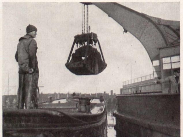
Bild 1. Ein Greifbagger verlädt den Schlick in Schuten
