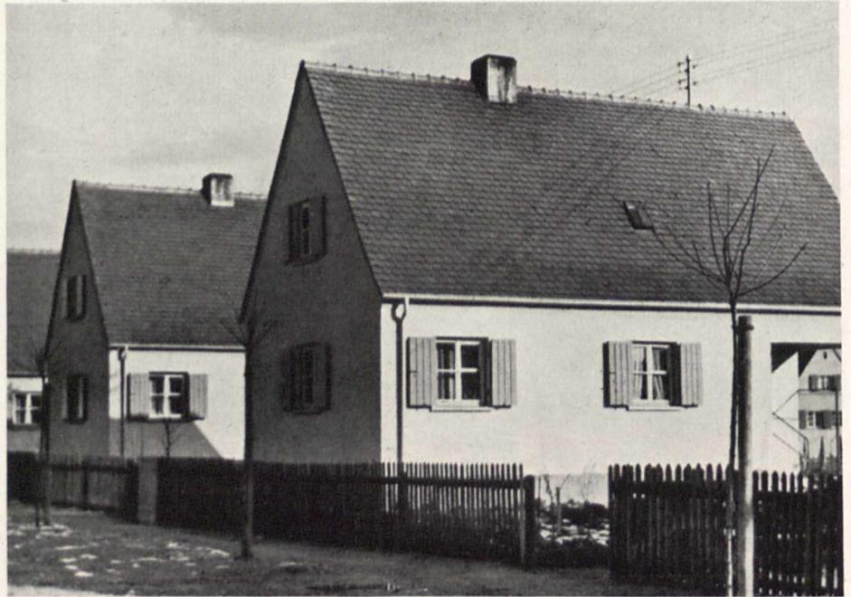
Bild 4. Gute Anbringung der Freileitungen mit Dachständern
