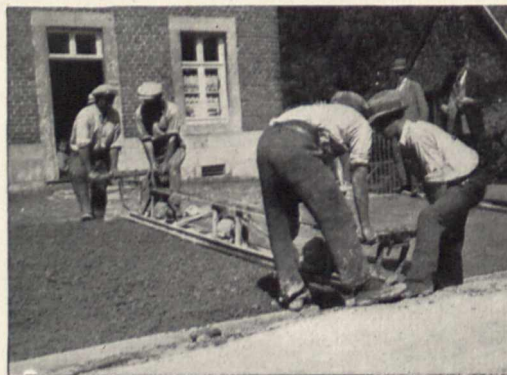
Bild 2. Oberflächenrüttler mit drei Rüttlern
