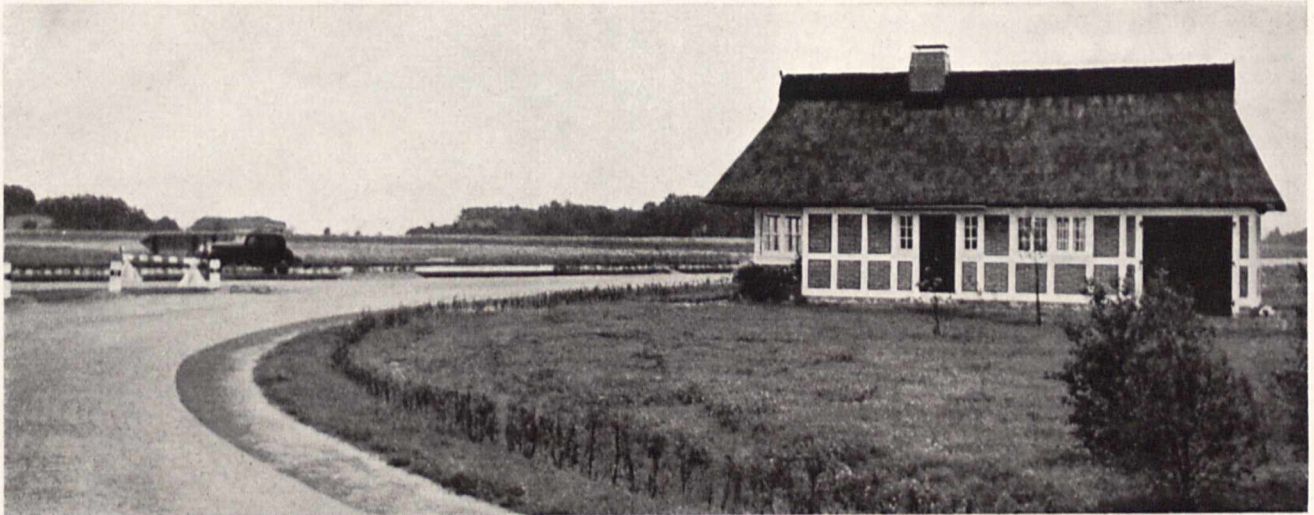
Bild 1. Aufsichtshäuschen Sittensen an der Reichsautobahn
