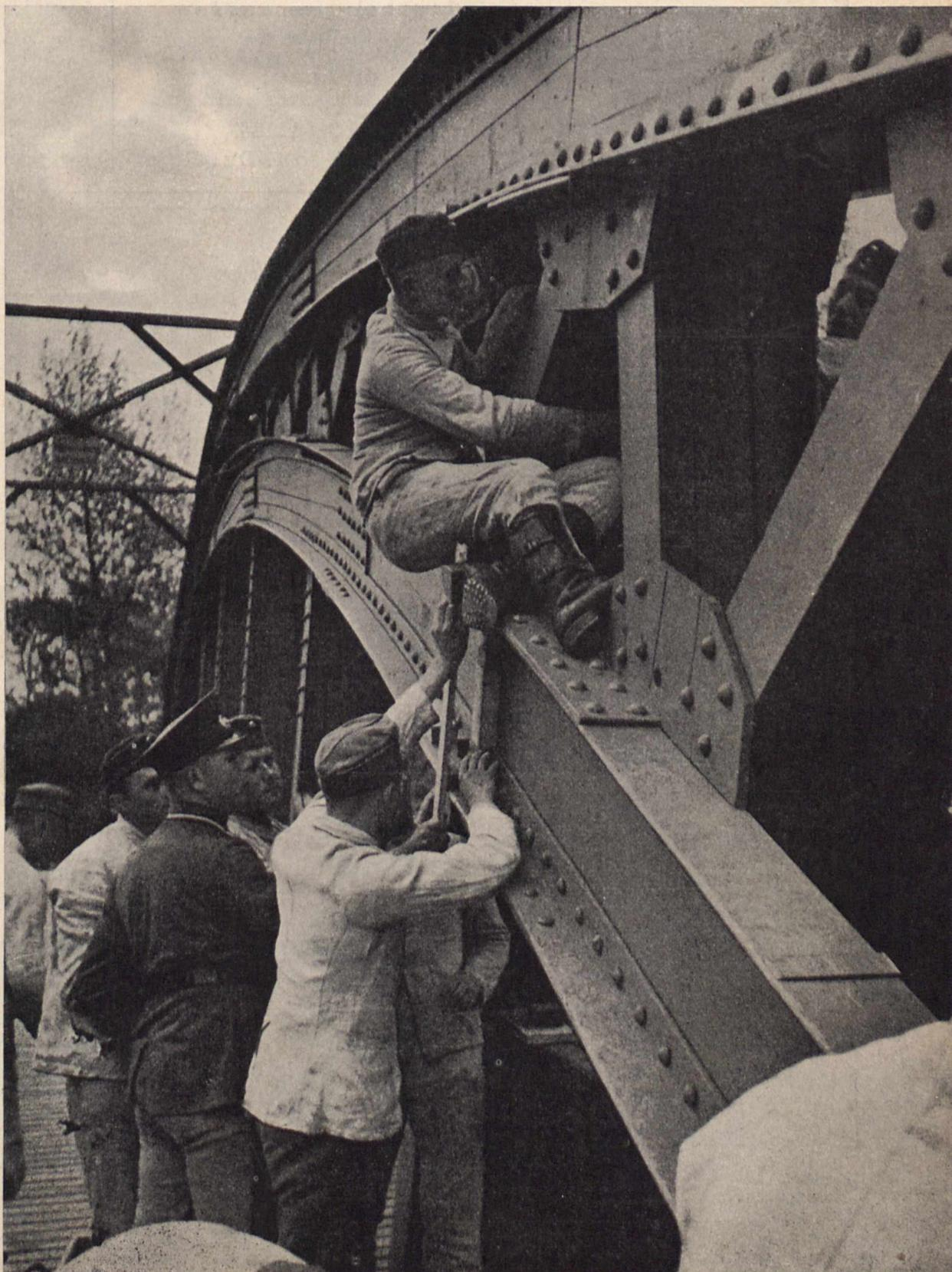
**Sprengladungen werden am Brückenmodell angebracht**
