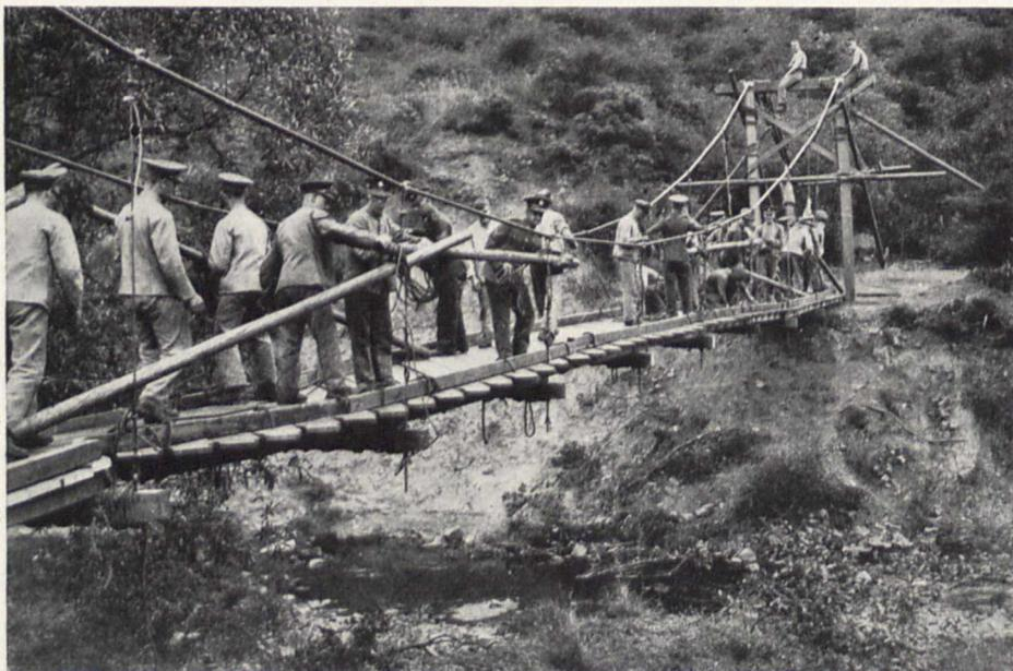
Bild 3. Englische Pioniere bauen eine Behelfsbrücke
