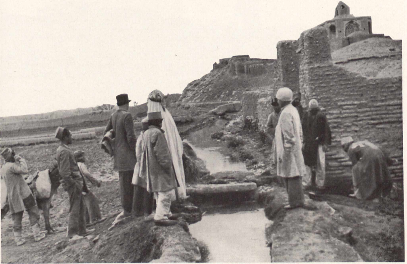
Bild 1. Am Eingang des Dorfes tritt das Kanatwasser in einem Bächlein an so hoher Stelle zutage, daß es noch „reitet“, d. h. daß es durch Kanäle noch zur Berieselung in alle Felder herabgeleitet werden kann
