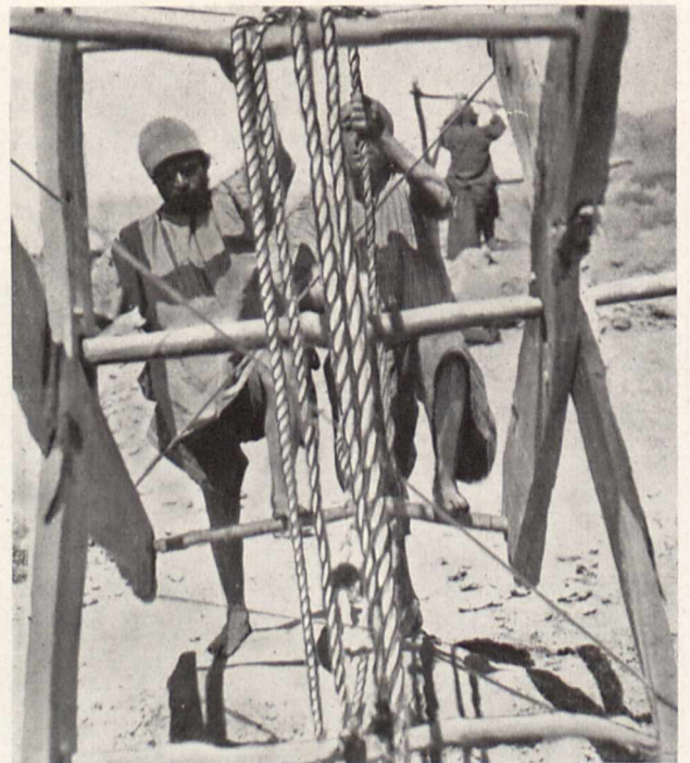
Bild 2. Beim Kanatbau wird über dem Schacht eine primitive, auf zwei Astgabeln ruhende Tretwinde aufgestellt. — Mit Füßen und Händen die Speichen niederdrückend, winden die Arbeiter mühselig am Seil kleine Ledersäcke mit dem ausgeräumten Erdreich herauf
