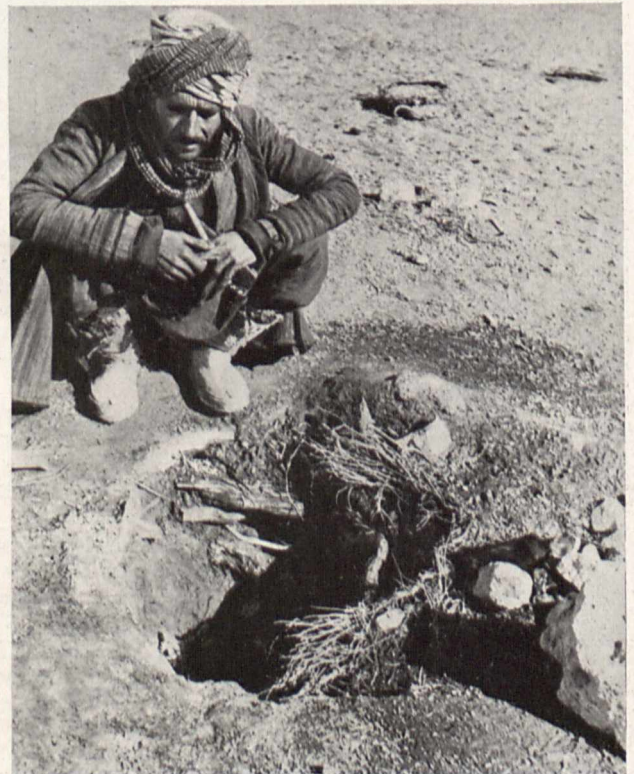
Bild 6. Der abgestützte Anfang eines Kanatschachtes
