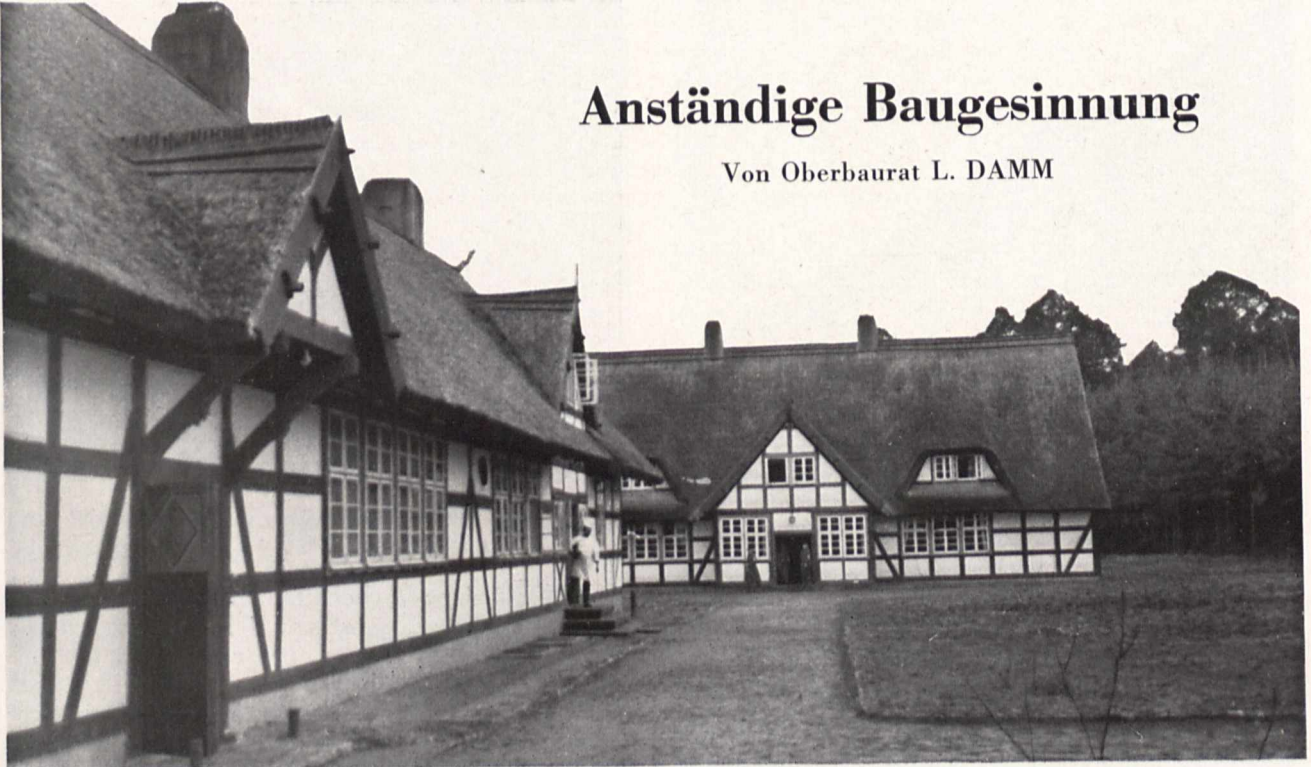
Bild 1. Arbeitslager am Werbellin-See, ein Beispiel für bodenständig gute und werkgerechte Einpassung in die Landschaft
