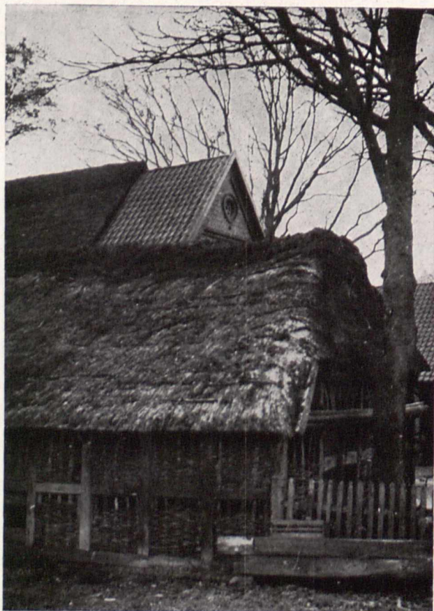
Bild 4. Strohgedeckte Bauten mit Pfannendach oder anderen Dachfetzen zu zerstückeln, ist nicht werkgerecht
