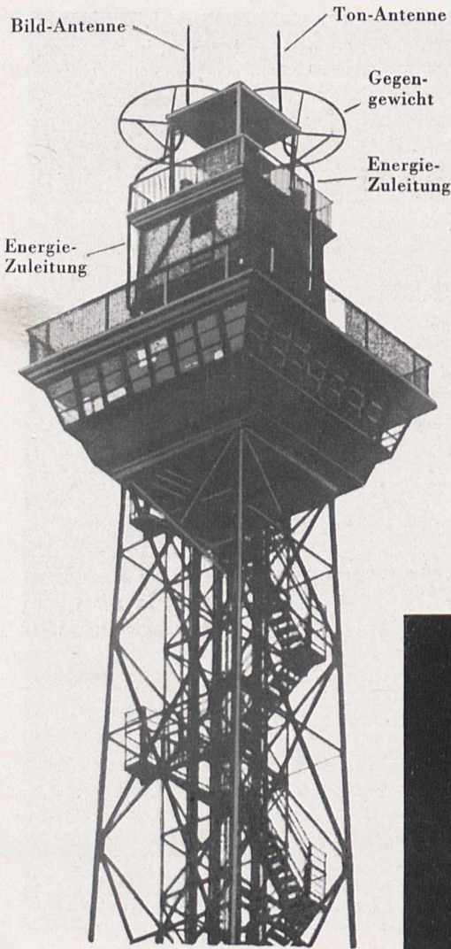
Bild 16. Ultrakurzwellen-Bild- und Ton-Antennen auf dem Funkturm Berlin-Witzleben
