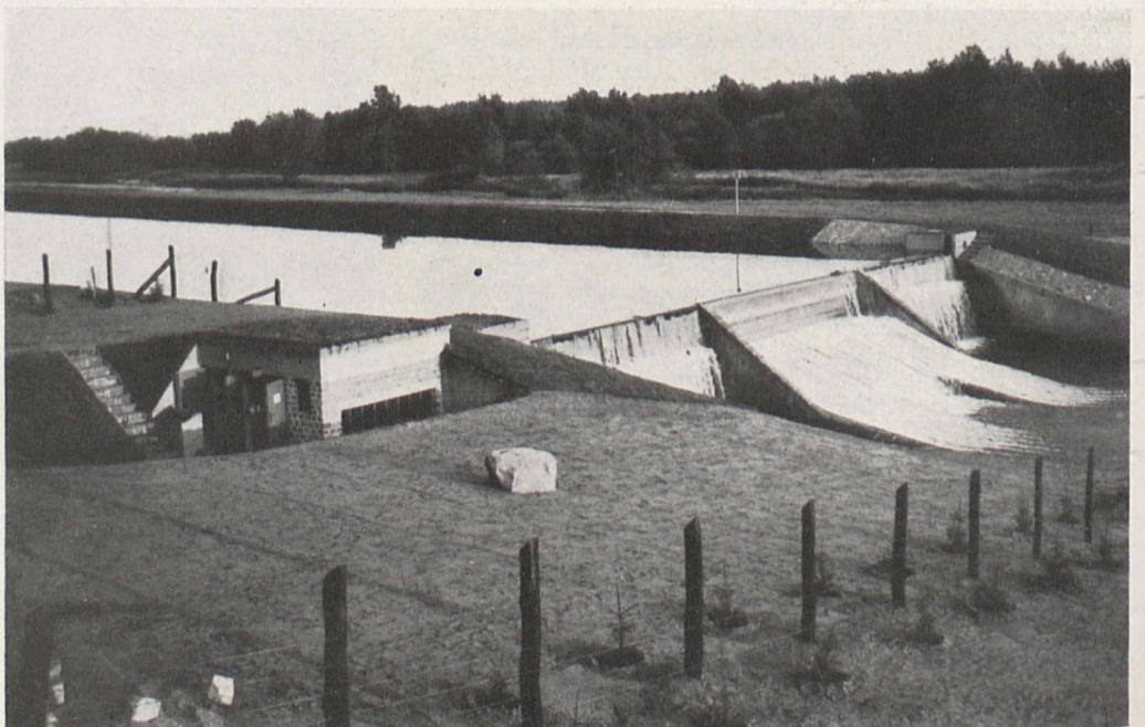
Bild 3. Das neue Unterwasserkraftwerk bei Rostin in Pommern Die Gebäulichkeiten liegen unter dem oberen Wasserspiegel
