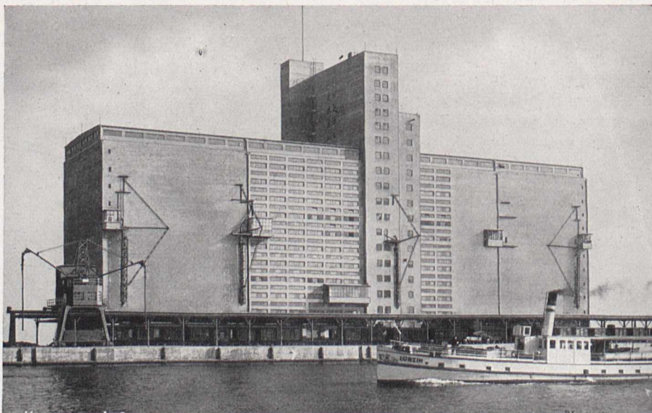
Bild 3. Einer der neuesten und größten deutschen Getreidespeicher (Stettin); seine Zellen fassen insgesamt 43 000 Tonnen Getreide
