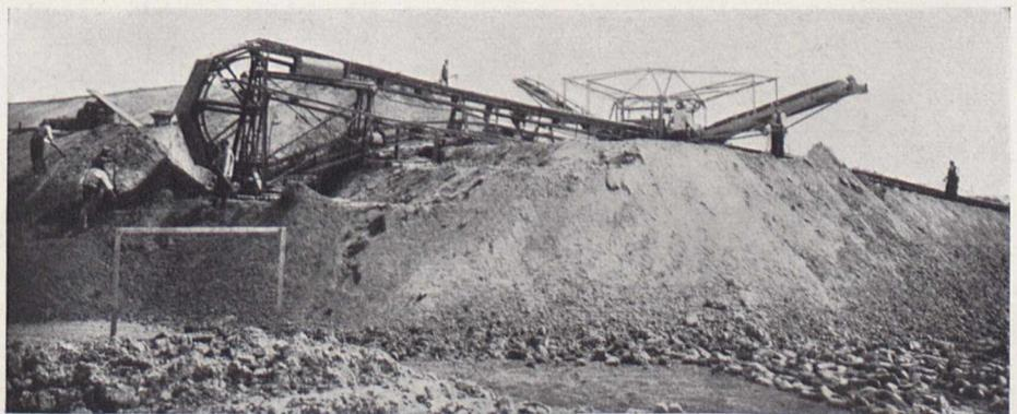
Bild 4. Der Plattenbandförderer an der Abschüttstelle
