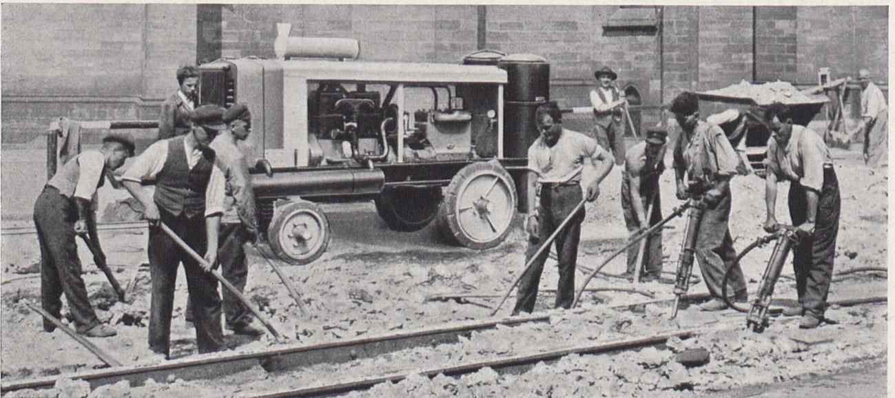
Holzgas-Kompressor zur Erzeugung von Druckluft.
