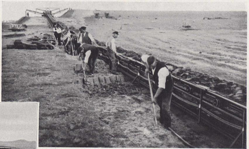
Bild 2. Die Arbeiter schaufeln Erde auf das laufende Band
