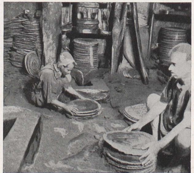
Bild 10. Füllen der gequetschten Leinsaat in Schilfkörbe
