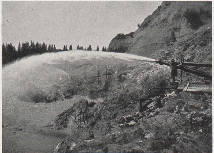
Bild 2. Wasserstrahlen fressen sich unter größtem Druck in die Kies-Bänke von You Bet hinein
