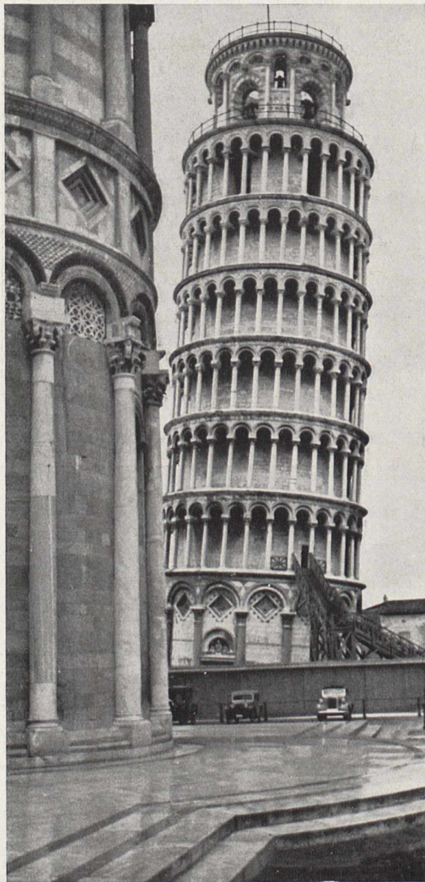
Bild 1. Der Schiefe Turm zu Pisa. Vom Domchor aus gesehen, tritt die Neigung besonders hervor. Vom dritten Stockwerk an hat man, als die Grundfesten sich senkten, nach Norden eingelenkt, so daß der Turm nicht nur schief, sondern auch krumm wurde. Eine hölzerne Außentreppe führt jetzt gleich hinauf in die erste Säulengalerie.
