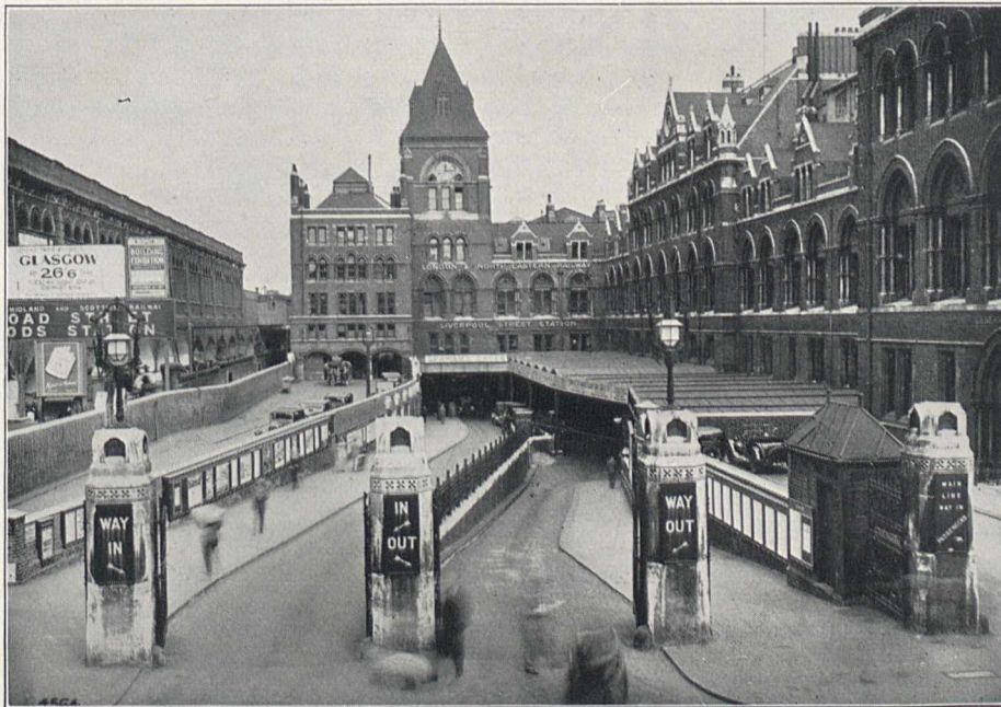
Bild 2. Bahnhofseingang in London mit Wagenanfahrt, die an den Querbahnsteig (Mitte des Bildes) und zum Fahrkartenverkauf (rechts im Bild) führt
