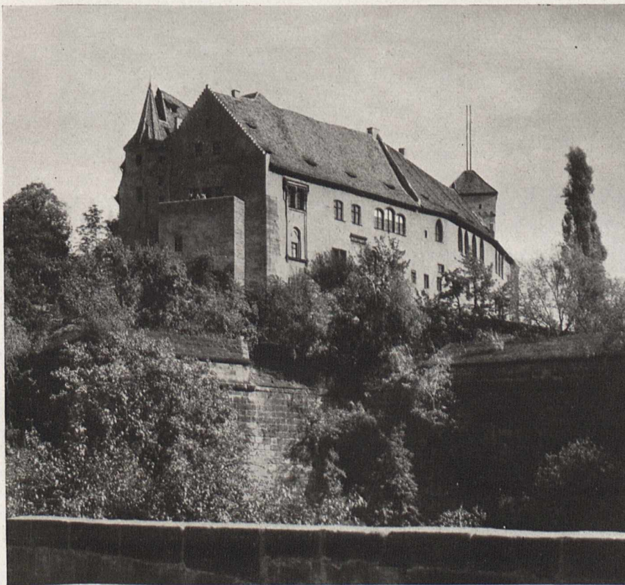
Bild 2. Der Söller an der Kaiserburg nach der Instandsetzung
