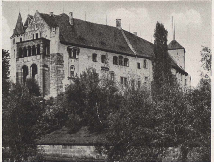
Bild 1. Die Kaiserburg in Nürnberg vor der Instandsetzung mit neuromanischem Söller (vgl. S. 816)
