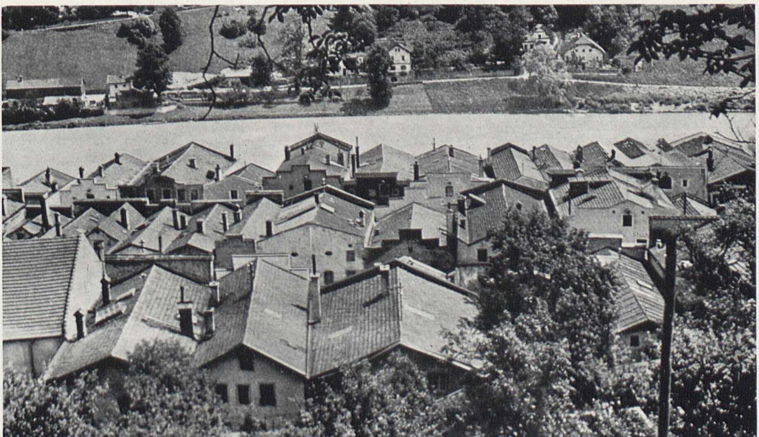
Bild 7. Die kennzeichnenden Reihen der sog. „Grabendächer“ in Burghausen an der Salzach (vgl. Bild 5)
