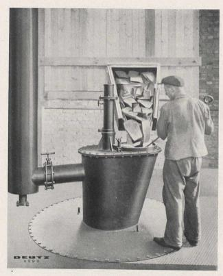
Bild 3. Aus dem Vorratsbunker wird der Holzvergaser beschickt
