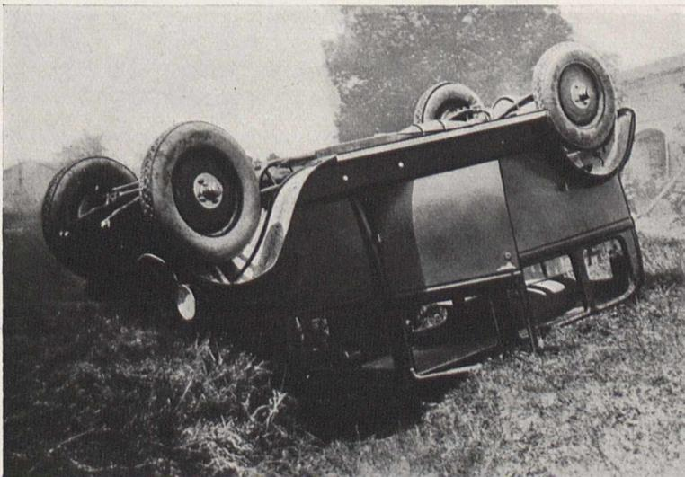
Bild 4. Selbst durch den Sturz erfahren die Stahlbleche der Karosserie keine Beschädigung
