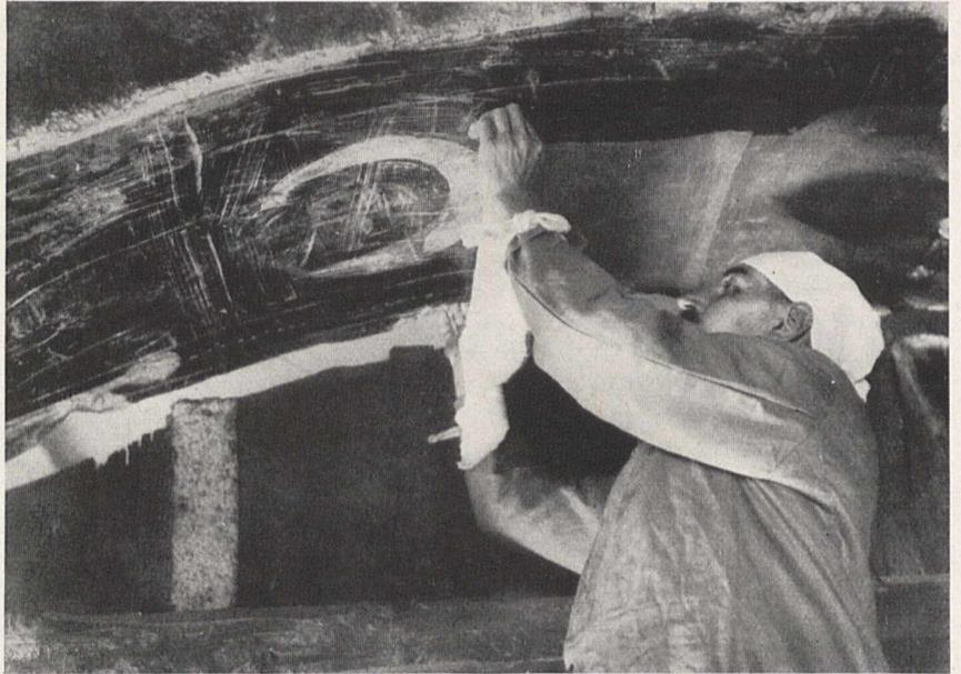
Bild 1. Auf die Wandmalerei werden mehrere Leinwandschichten aufgeklebt, welche bei der Entfernung des Freskos von der Wand den Träger bilden und das Aufrollen ermöglichen
