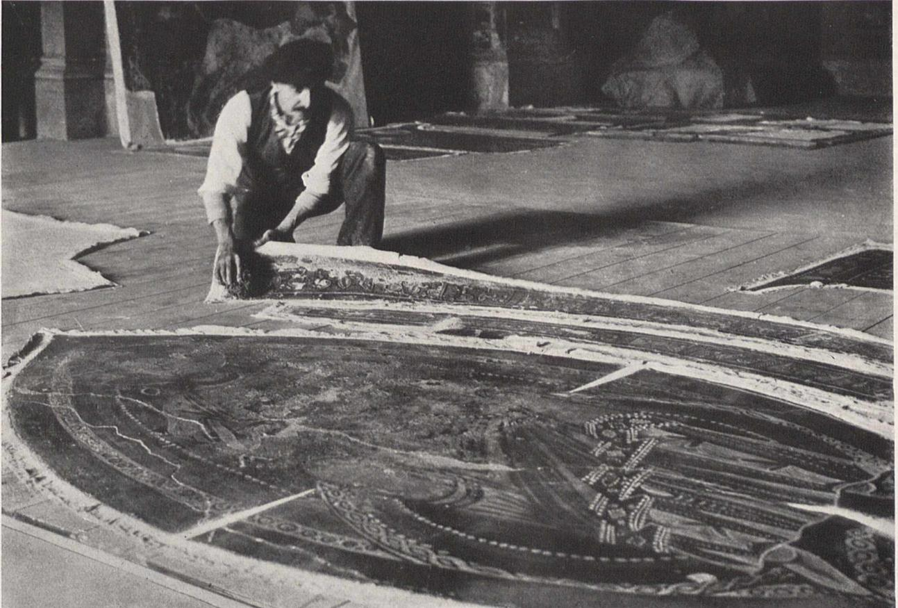
Bild 3. Nachdem auf der Rückseite des Putzes die neuen Leinenschichten als endgültiger Träger aufgeklebt sind, werden die auf der Bildseite aufgebrauchten Leinenschichten abgeweicht und das Fresko tritt hervor
