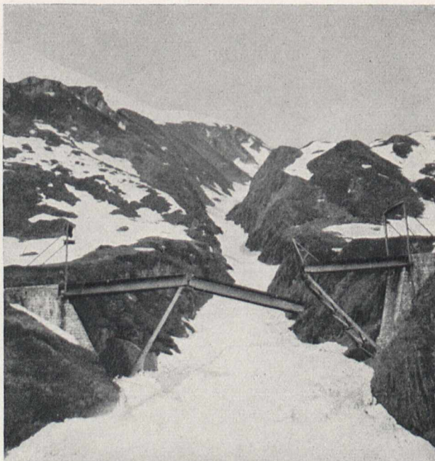
Eine zerlegbare Brücke an der Furkastraße, die im Herbst zusammengeklappt wird, damit sie nicht durch Lawinen zerstört wird. Im Frühjahr wird sie wieder hochgezogen und befestigt. Das Bild zeigt, wie das Mittelstück der Brücke hochgezogen wird.
