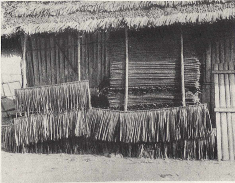
Bild 8 (links). Atap (Blattziegel) aus Sagoblättern hergestellt. Die Wände des Hauses sind aus den Blattstielen hergestellt
