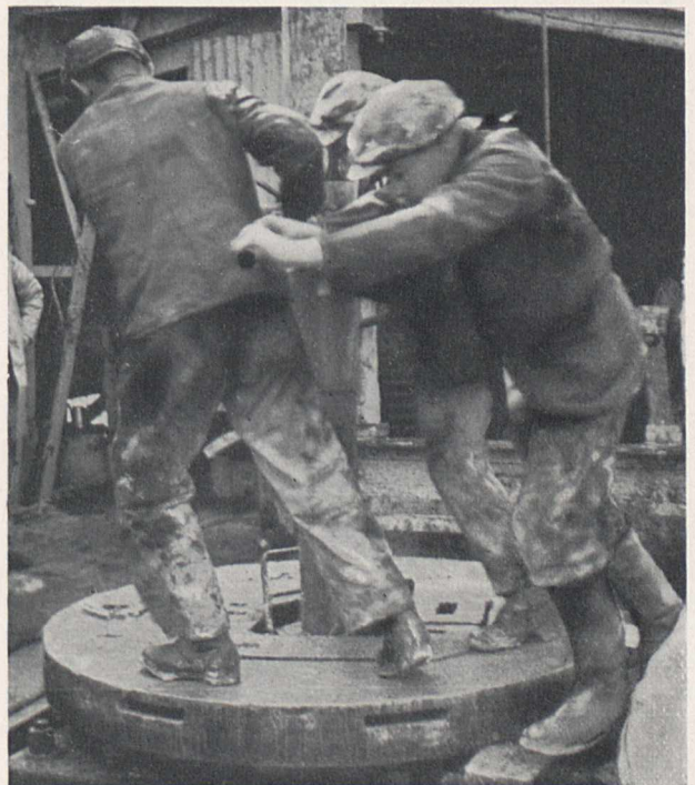
Ein neues Bohrgestänge ist an das eingetriebene angesetzt und wird verschraubt
