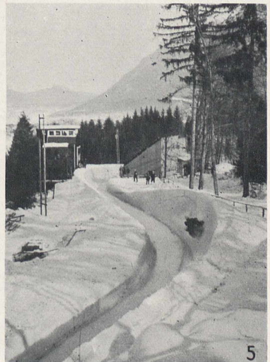
Bild 1. Wie das Kilian-Looping entstand: Die beiden Hauptkurven sind genau abgesteckt; rechts das Telefonhaus (für eilige Meldungen).
