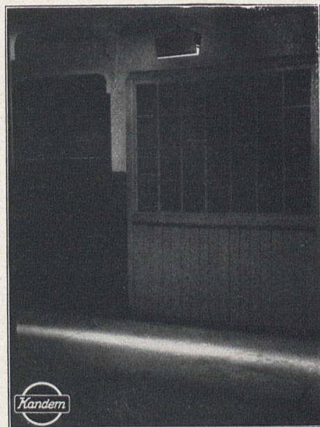
Bild 1. Fluchtwegbeleuchtung und Markierung durch „Kandem“-Fluchtwegleuchte bei völlig abgeschalteter Raumbeleuchtung. Links oben die „Kandem“-Leuchte.
