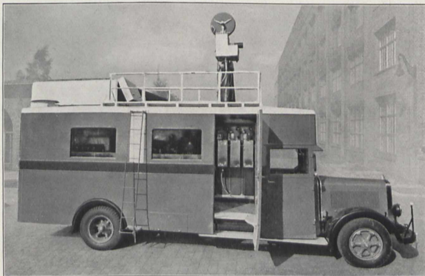
Bild 2. Fernseh-Aufnahmewagen für das Zwischenfilmverfahren der Fernseh A.-G.
