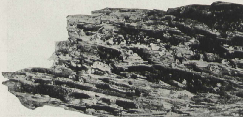
Fig. 4. Holzstück, durch Holzwürmer (Balaniden) vollständig zerstört
