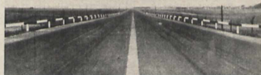
Fig. 12. Einfriedigung der Autostraße Köln—Bonn. — Durch großen Pfostenabstand wird eine federnde Wirkung des Geländers erreicht.
