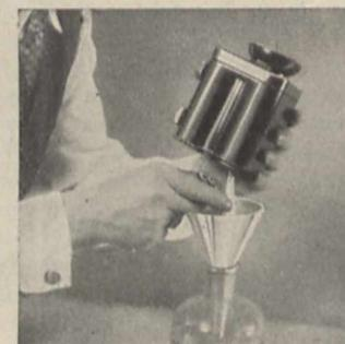
mit reinem Wasser zu füllen. Danach wird der Film herausgenommen und zum Trocknen aufgehängt. Nach sorgfältiger Reinigung und Trocknung ist der Automat für neue Verwendung bereit. Nahezu alle bekannten Film-Marken der Formate 6×6, 6×9, 3×4 und 4×6½ lassen sich im Optochrom-Automat entwickeln.
