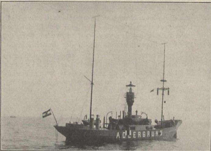
Fig. 1. Funkfeueranlage an Bord eines Feuerschiffes
