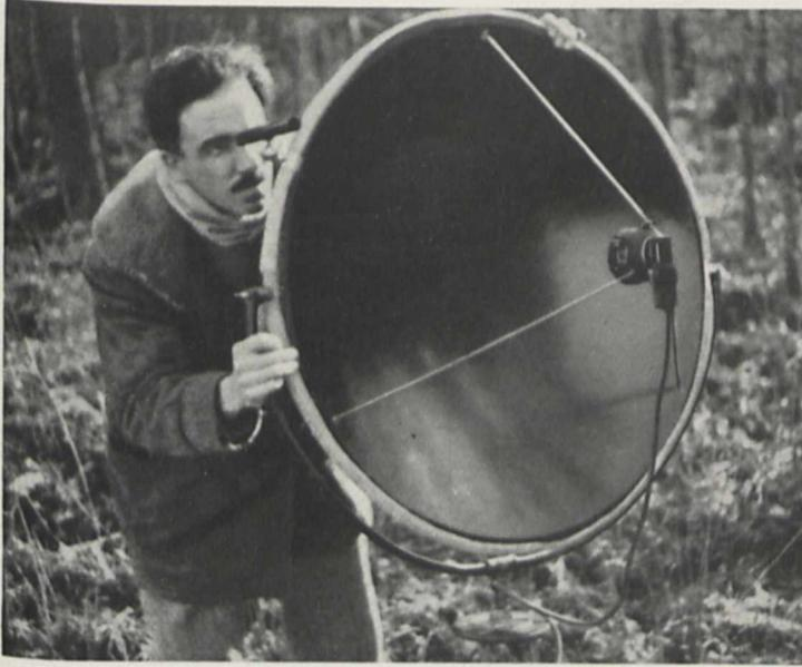
Fig. 2. Der parabolische „Tonsammler“, der mit Hilfe der Visiereinrichtung an seinem Rand genau in die Richtung des singenden Vogels eingestellt werden kann
