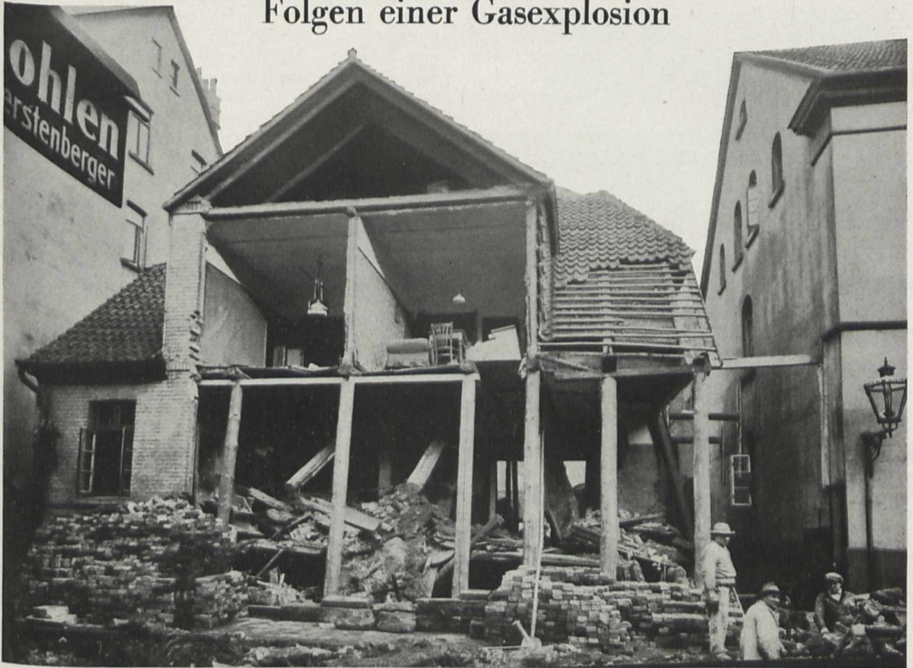
Bei der Vornahme von Reinigungsarbeiten an der Gasleitung im Keller des hier abgebildeten Hauses entzündete sich auf unaufgeklärte Weise (harter Schlag beim Arbeiten, Undichtigkeit eines Schornsteins, mangelhafter elektrischer Schalter?) das Gas zu einer 20-30 cm langen Stichflamme. Ein Schließen des Absperrhahnes hatte keinen Zweck, da die Flamme vor diesem Hahne brannte. — Löschen der Flamme mit Wasser oder Ersticken
