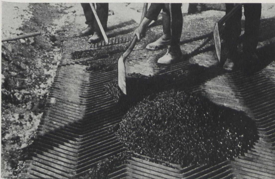
Fig. 4. Verteilen der Füllmasse zwischen den Rippen des Stahlrostkörpers
