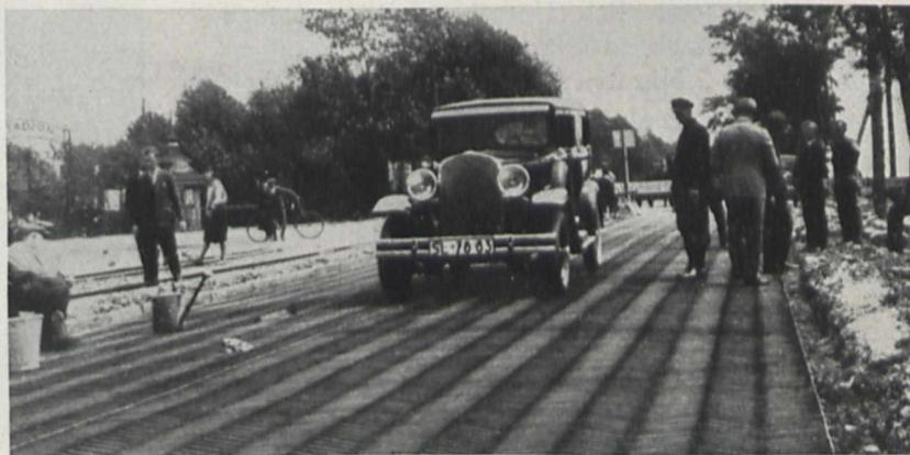
Fig. 5. Ohne störende Verkehrsumleitung kann die Stahlrostdecke, auch vor der Ausfüllung, von jedem Fahrzeug gleitschutzsicher befahren werden
