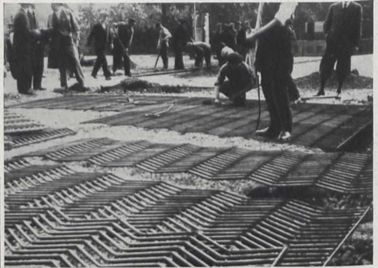
Fig. 1. (oben). Zusammenbau der einzelnen in der Werkstatt zusammenschweißten Stahlrostelemente auf der Straße
