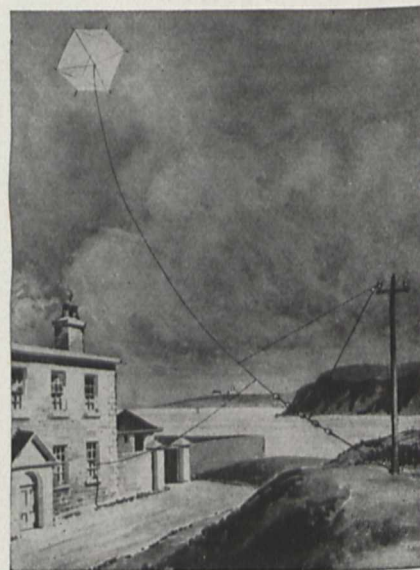
Fig. 6. Die Drachen-Empfangs-Anlage St. Johns (Neufundland) nahm am 12. Dezember 1901 die ersten drahtlosen Signale von Europa auf
