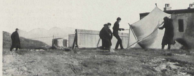
Fig. 5. Der Drachen auf der Empfangs-Anlage St. Johns (Neufundland), der den Empfangsdraht halten sollte (1901), wird unter Aufsicht Marconis aus dem Schuppen gezogen. — Kurz nach Empfang der ersten über den Ozean gefunkten Zeichen wurde der Drachen vom Sturm aufs Meer hinaus abgetrieben.
