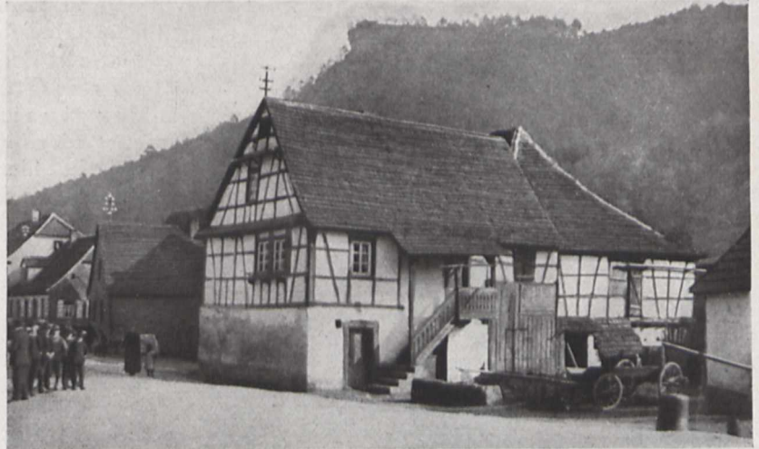
Fig. 5. Im Unterstock befinden sich der Keller und die Kellerstallung; im Oberstock (Wohnstock) die Küche, die Stube und die Schlafräume Rinnthal in der Rheinpfalz.
