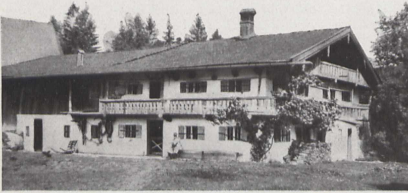
Fig. 1. Im Unterstock befinden sich die Küche, die Stube, der Stall und die Vorratsräume; im Oberstock die Schlafräume. Degerndorf im Inntal in Oberbayern.
