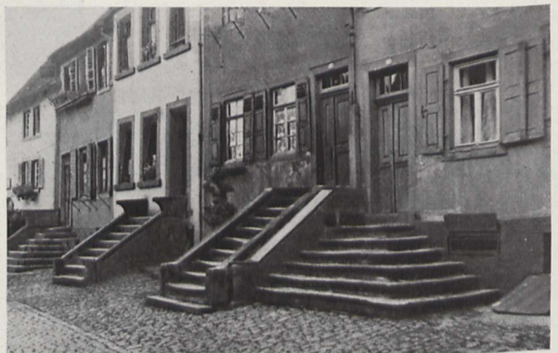
Fig. 8. Bei der Weiterentwicklung vom Dorfhaus zum Stadthaus verbleibt in der Rheinpfalz der Fußboden des ersten Wohnstockes meist zunächst noch hoch über dem Erdboden, und es ergeben sich häufig weit in die Straße hineinspringende Freitreppen.
