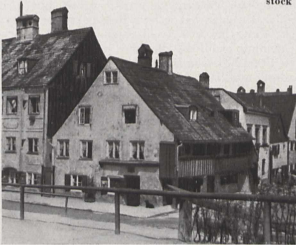
Fig. 4. Bei der Weiterentwicklung vom Dorfhaus zum Stadthaus verbleibt in Oberbayern der Fußboden des unteren Wohnstockes fast immer zunächst zu ebener Erde.
