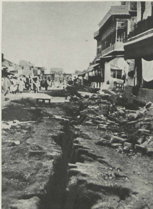
Tiefe, lange Erdspalten entstanden bei dem kürzlichen heftigen Erdbeben in der Stadt Bettiah im Distrikt Bihar nördlich des Ganges in Indien. Die Trümmer der zahlreichen zerstörten Gebäude bedeckten die Straßen. Die Landschaft in diesem Gebiet sieht völlig verändert aus, so als ob lange, in nordwestlicher Richtung ziehende Wellen auseinanderbarsten.
