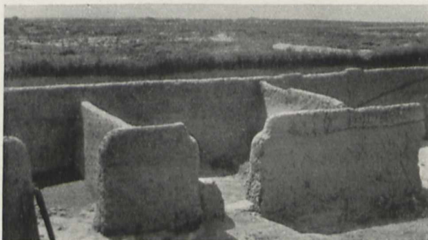
Fig. 5. Offene Getreidespeicher. Die Regenmenge ist so gering, daß diese Art von Getreidesilo genügt. Allenfalls kann man das Korn mit Segeltuch zudecken. Die Wände sind ohne Grundmauern aus Lehm aufgeführt.
