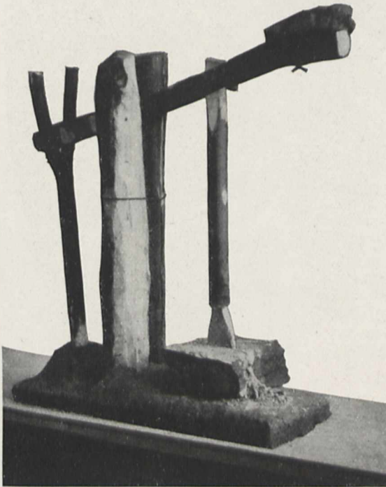
Fig. 4. Steinsäge-Rekonstruktion des Staatl. Museums in Danzig
