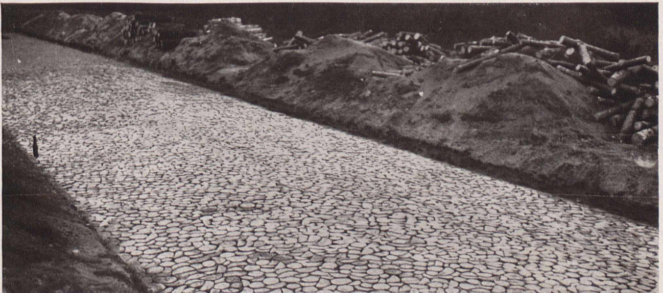
Fig. 2. Die mit Brennholz fertiggeplasterte Landstraße in Birkenwerder. — Rechts oben: Die noch ungeschnittenen Knüppel
