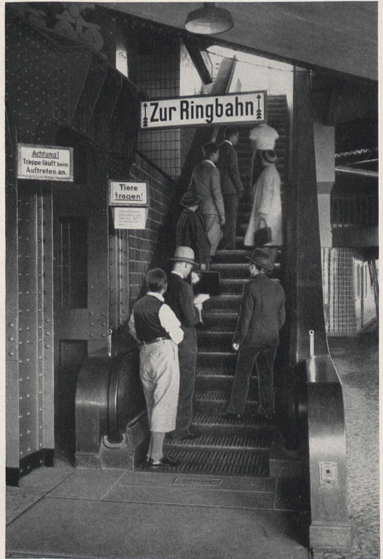
Fig. 3. Fahrtreppe mit Fußtrittschaltung auf dem S-Bahnhof Schöneberg (Berlin)
