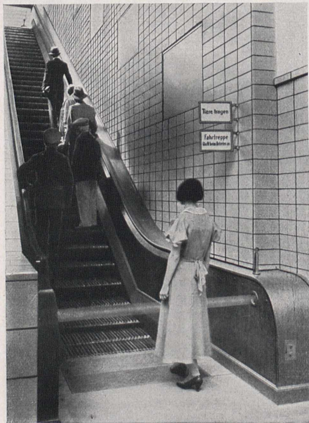
Fig. 4. Fahrtreppe mit Lichtstrahlensendung auf dem S-Bahnhof Innsbrucker Platz (Berlin). Die Dame durchschreitet die (in Wirklichkeit unsichtbare) Lichtschranke.
