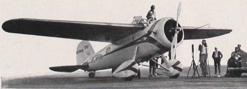
Fig. 2. Das gebräuchlichste amerikanische Schnellverkehrsflugzeug, der Lockheed-Vega-Eindecker (ohne hochziehbares Fahrgestell). Diesen Typ benutzte der Weltflieger Mattern.
