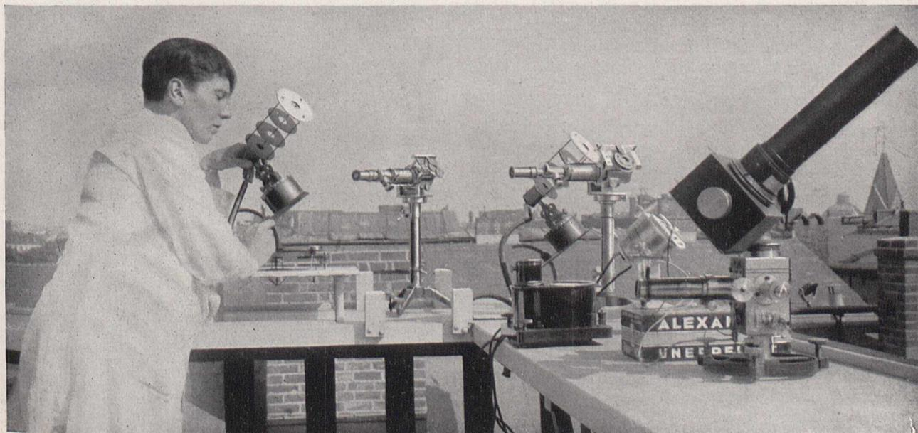
Fig. 2. Station auf dem Dach des Berliner Instituts für Strahlenforschung. Hier wird die Strahlungsintensität der verschiedenen Strahlenarten der Sonne gemessen.
