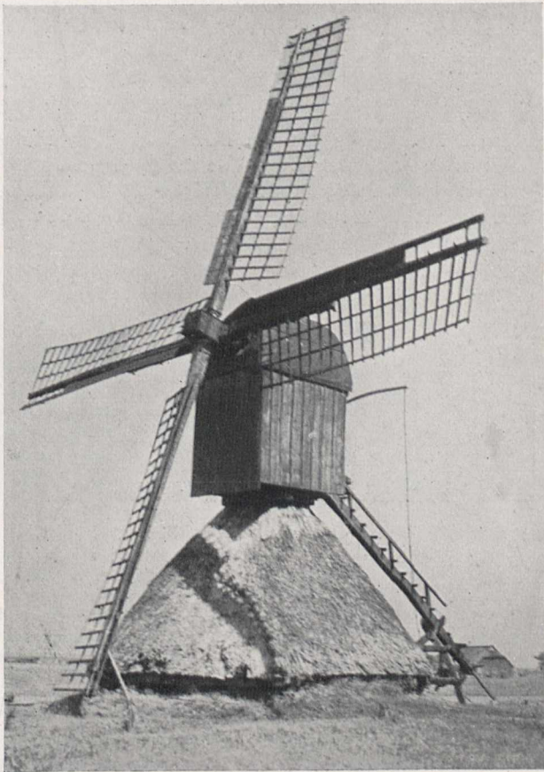
Fig. 3. Schöpfmühle auf der Wister-Marsch mit den üblichen alten Flügeln Phot. Issleib, Hamburg
