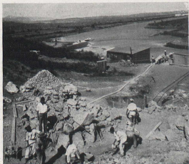
Fig. 5. Blick vom Steinbruch auf den Kanal Mipena und die Bojana-Niederung, in deren Nähe die Meersaline gebaut wird
