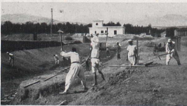
Fig. 3. Türkische Arbeiter beim Kanalbau der Meersaline vom Meer zu den Kristallisationsbecken. Im Hintergrunde das Pumpenhaus.
