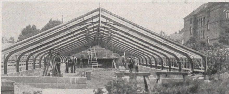
Fig. 4. Erwerbslose bei Fundamentierungs- und Montage-Arbeiten der freitragenden Kuppler-Gewächshausbauten in Berlin-Britz
