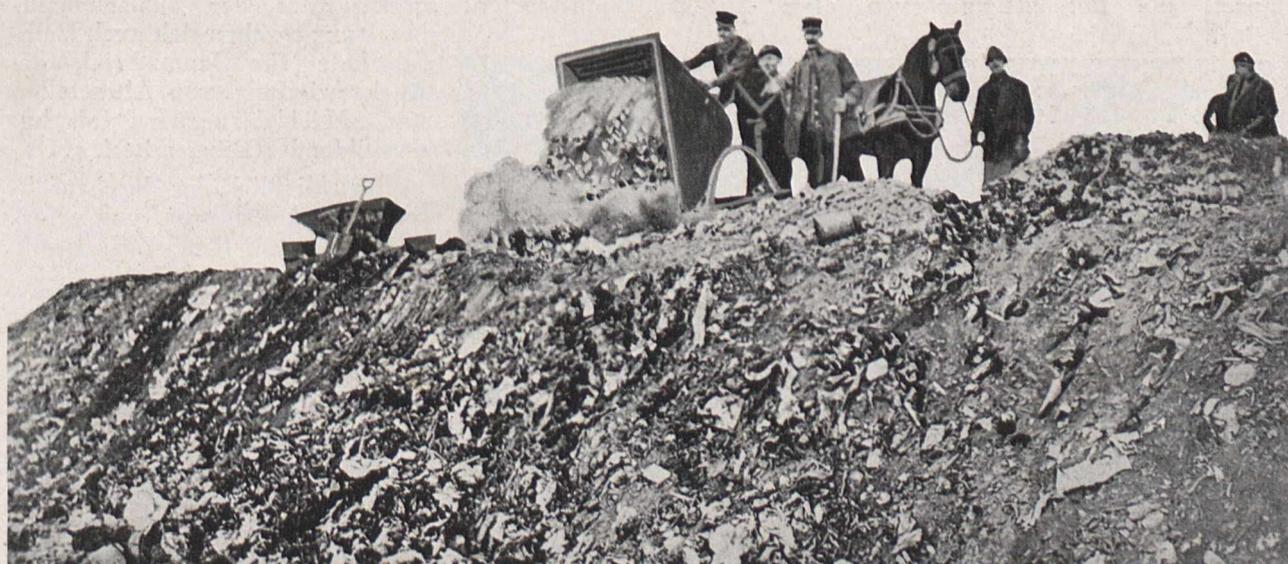
Fig. 2. Bei der bisherigen unhygienischen Müllablagerung bleibt das Gelände trotz sorgfältigster Planierung auf Jahrzehnte hinaus für Anbauversuche ungeeignet
