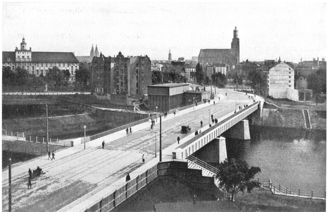
ABB. 23: BLICK AUF DIE BRÜCKE VOM RECHTEN UFER
