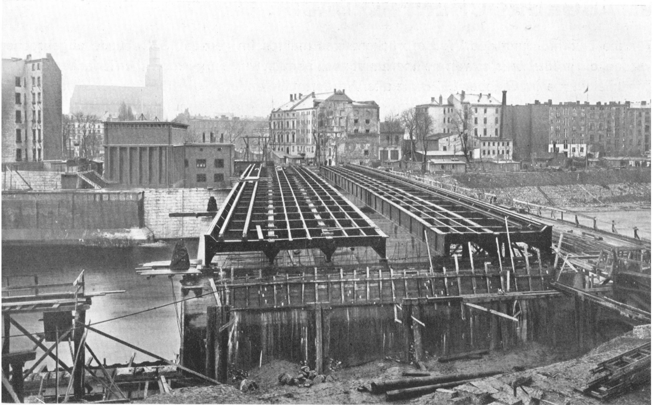
ABB. 19: BLICK AUF DAS EISERNE TRAGWERK
