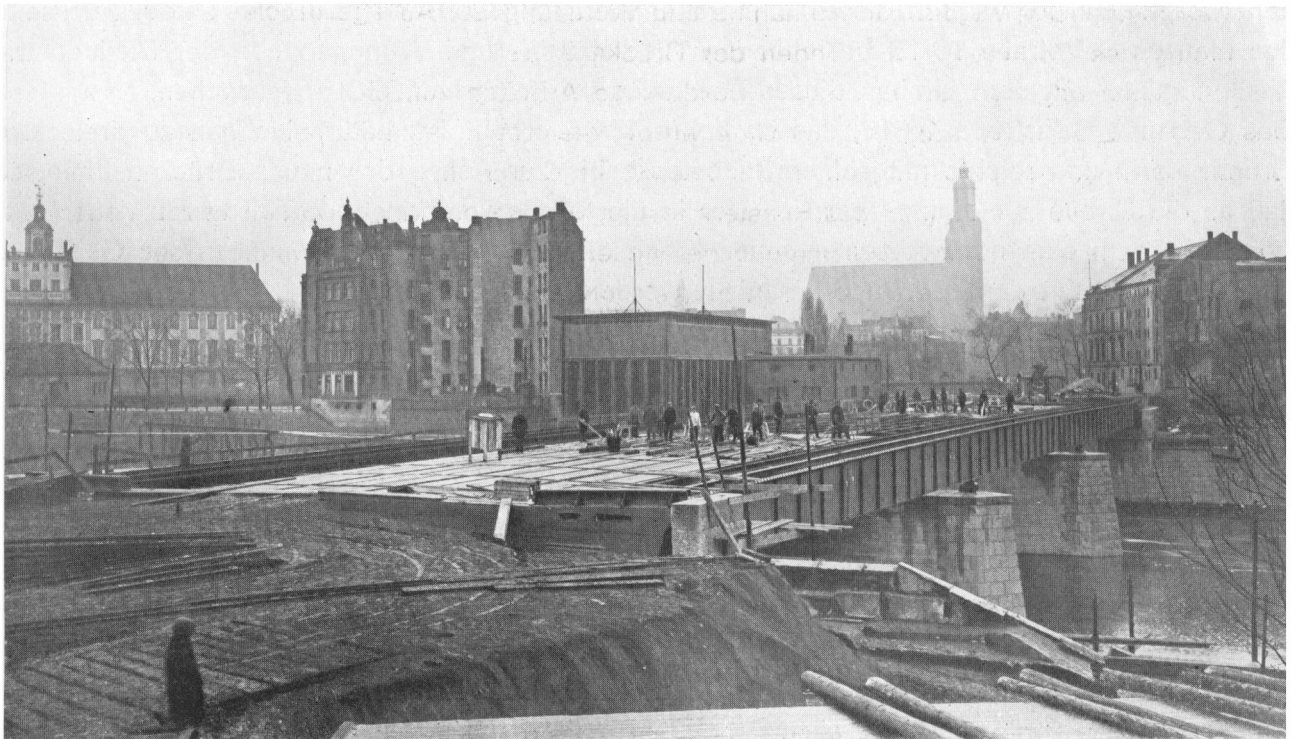
ABB. 20: EINSCHALEN DER FAHRBAHNTAFEL
