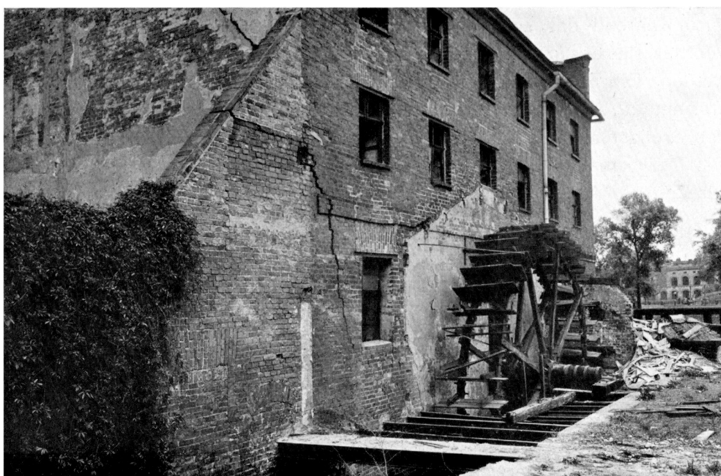
ABB. 27: DIE ALTE RÖTE- MÜHLE AM RECHTEN UFER DER NORDERODER
