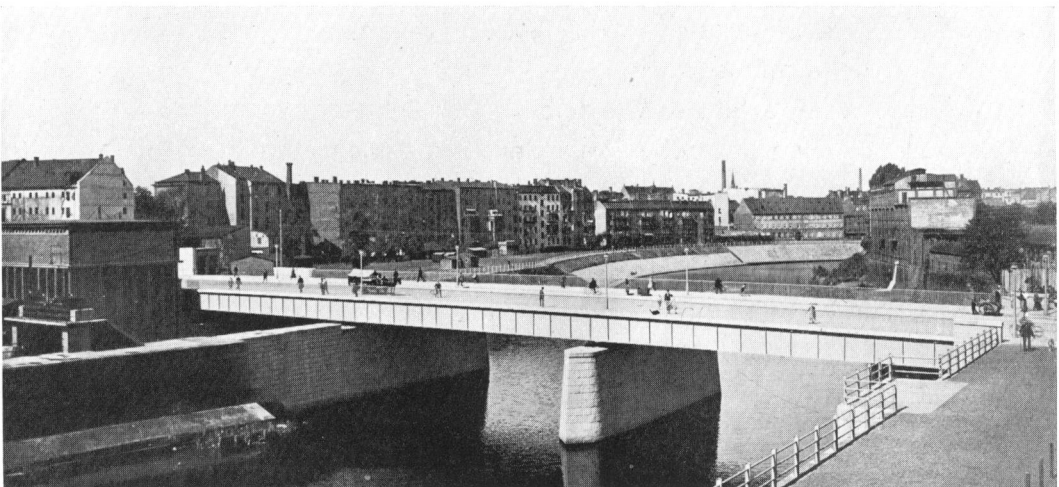
ABB. 22: BLICK AUF DIE BRÜCKE VON DER OBER- STROMSEITE
