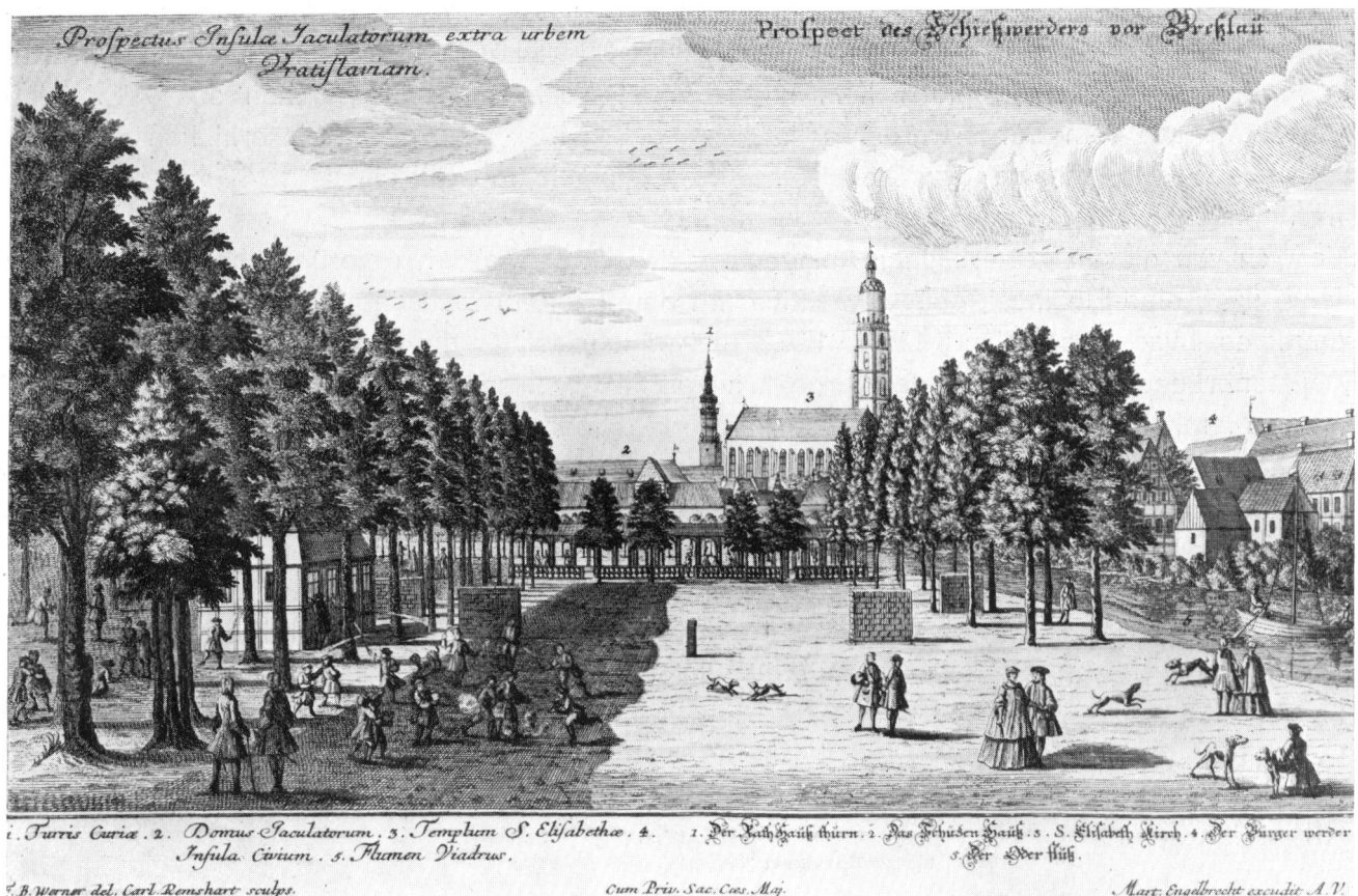
ABB. 2: KUPFERSTICH AUS DEM JAHRE 1740 VON DEM DAMALIGEN SCHIESSWERDER AN DER STELLE DER NEUEN BRÜCKENRAMPE ZWISCHEN SALZSTRASSE UND NORDERODER
