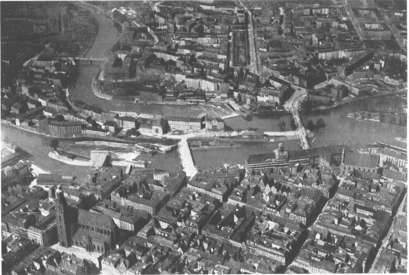
ABB. 3: FLUGBILD VOR DEM AUSBAU DES WERDERBRÜCKENZUGES
